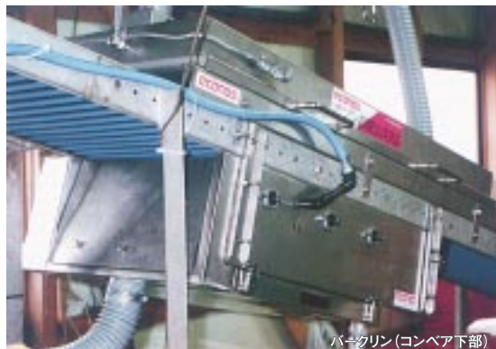
パーブローア (コンベヤ上部)
